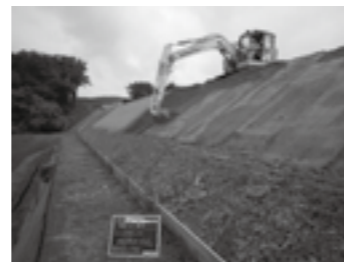
ICT建機による掘削・法面整形作業 ▶P.5
