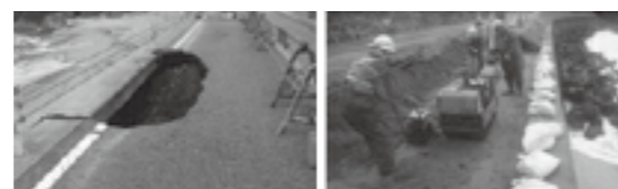
道路陥没(平成27年1月) (同補修状況) ▶P.15
